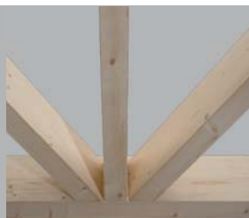
Orthogonaler und horizontal geneigter Anschluss HT – NT.
