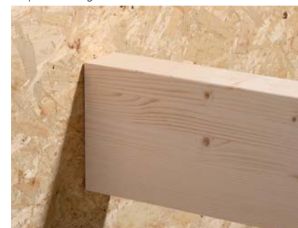
Nebenträger- oder Pfettenanschluss an OSB im freien Feld.
