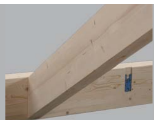
Vertikal nach oben geneigter Anschluss Haupt-/Nebenträger
