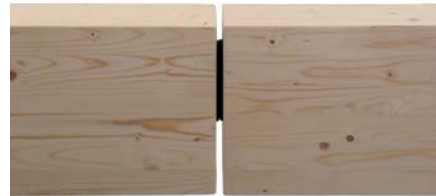
Anschluss einer Gerberpfette mit Schattenfuge
