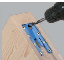
Einbringen der Bohrung für die Sogsicherung z.B. am Nebenträger.
