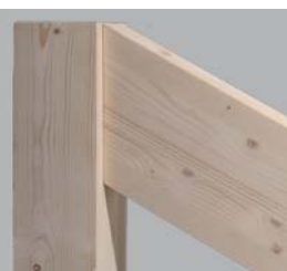
Vertikal nach unten geneigter Anschluss: Stütze-Riegel.
