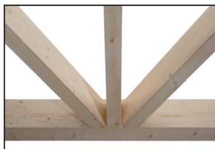
Orthogonaler und horizontal geneigter Anschluss Hauptträger – Nebenträger.
