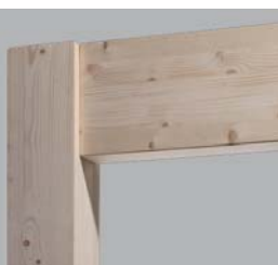
Orthogonaler Anschluss: Stütze-Riegel.
