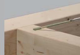
Einschrauben der Sogsicherung (BiRA®-HK-Schraub-Verbinder).
