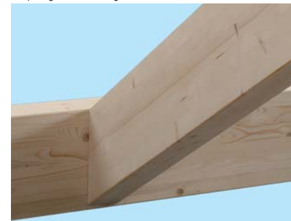
Vertikal nach oben geneigter Anschluss/ Haupt-/Nebenträger.
