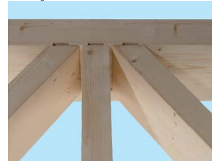
Orthogonaler und horizontal geneigter Anschluss Hauptträger – Nebenträger.
